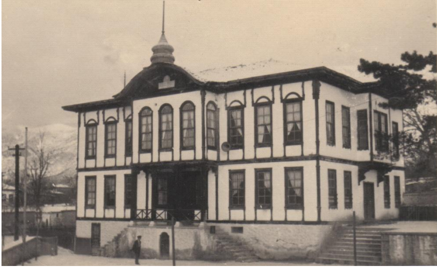
Uzun yıllar boş kalan eski İdadi binası ortaokul olduktan sonra (1950)
