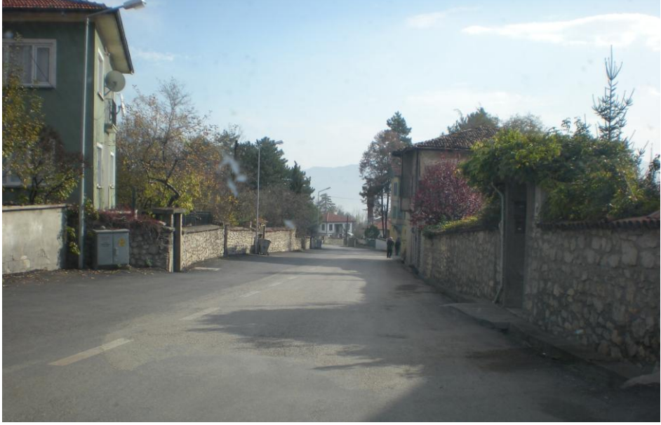
Arslanlar-Kavaklar-Köyü güzergahında genişletilen yoldan bir bölüm
