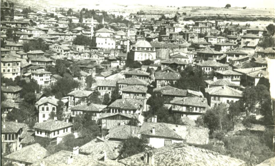
İsmet SARAÇOĞLU Koleksiyonundan Safranbolu'nun eski bir görünümü Ödünsüz uygulanacak ilke: Eski kente çağdaş yönetim
