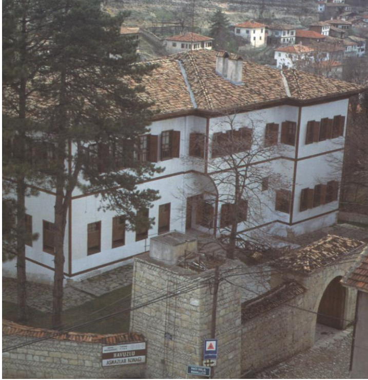
Havuzlu Asmazlar Konağı (Fotograf: Aytekin KUŞ)
